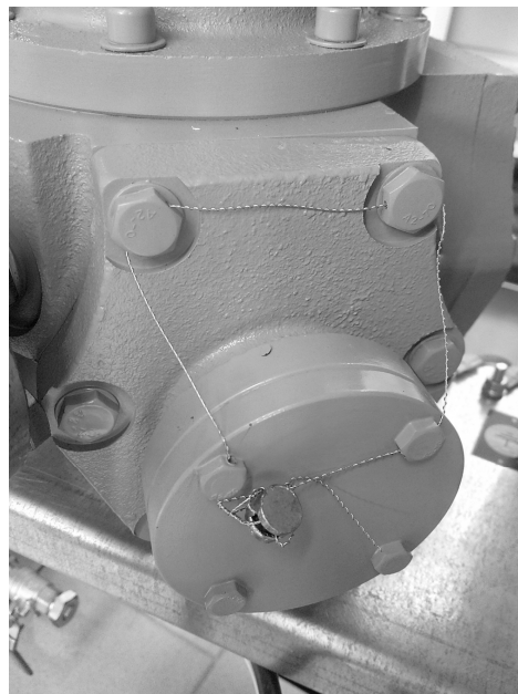
Рисунок В.2 – Схема пломбировки измерителя объема СУГ
